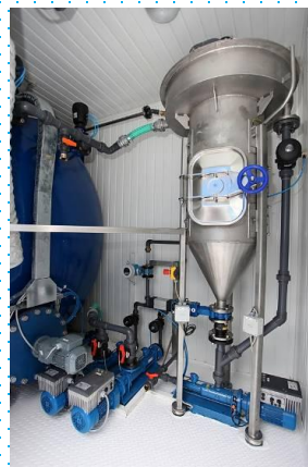
Сепаратор ExSep для предпочистки сточных вод перед мембранными модулями
